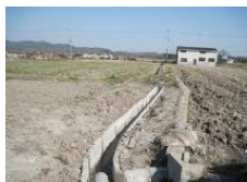
水路更新工事(素掘り水路をコンクリート製水路へ)(植田)
