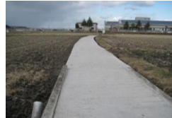
農道コンクリート舗装工事(中)
