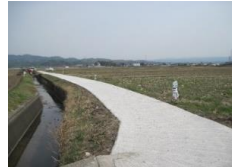
農道コンクリート舗装工事(里)
